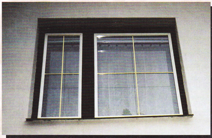
Příklad renovovaného okna (zabudovány ozdobné mřížky)
