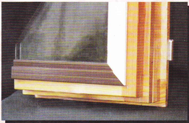
Pohled na vnější stranu renovovaného okna (vzorek)
