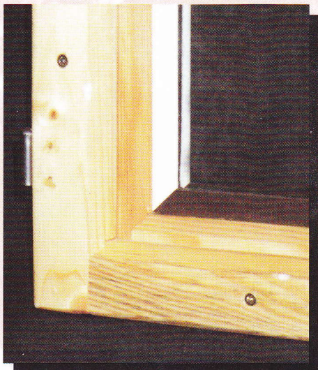
Pohled na vnitřní stranu
